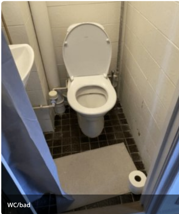
Københavertoilet med fliser på gulv og væg.
